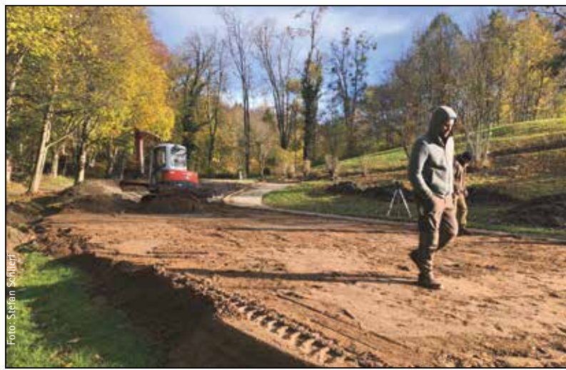
An der Teebox 18 war ein totaler Neubau mit Bodenaustausch und Rollrasen notwendig.
